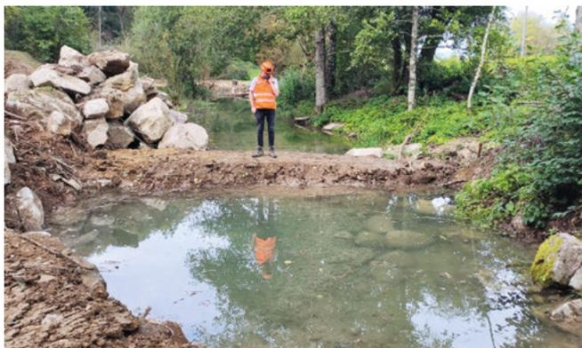
Bild 6: Vorne die mit den Bauarbeiten aufgedeckte Fließquelle, hinten der aufgedeckte Giessen im ‚Rohzustand‘. Ein Giessen wird aus Quellwasser und – in unverbauten Gewässern – von im Boden nachfließendem Bachwasser gespeist.
